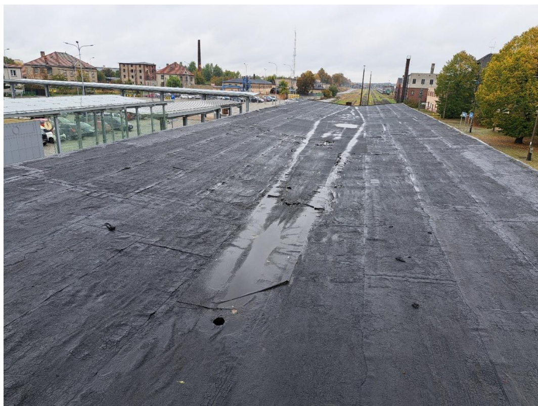
Zły stan techniczny pokrycia bitumicznego dachu.
