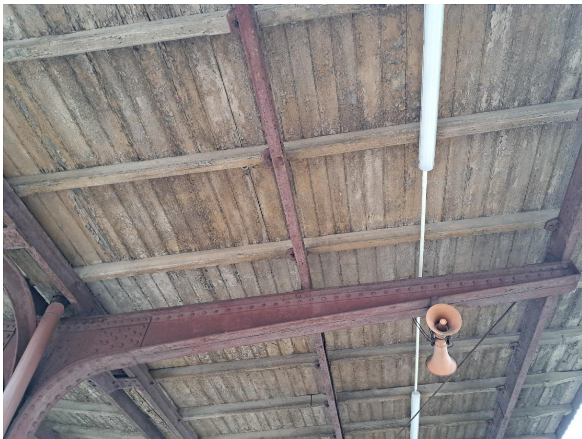
Stan techniczny elementów drewnianych zadaszzenia: obudowa rynny, poszycie, deski czołowe.
