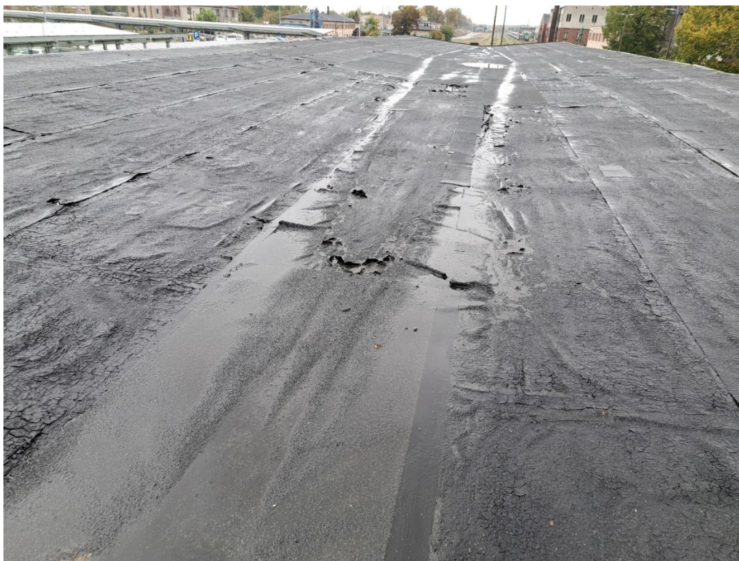
Zły stan techniczny pokrycia bitumicznego dachu.
