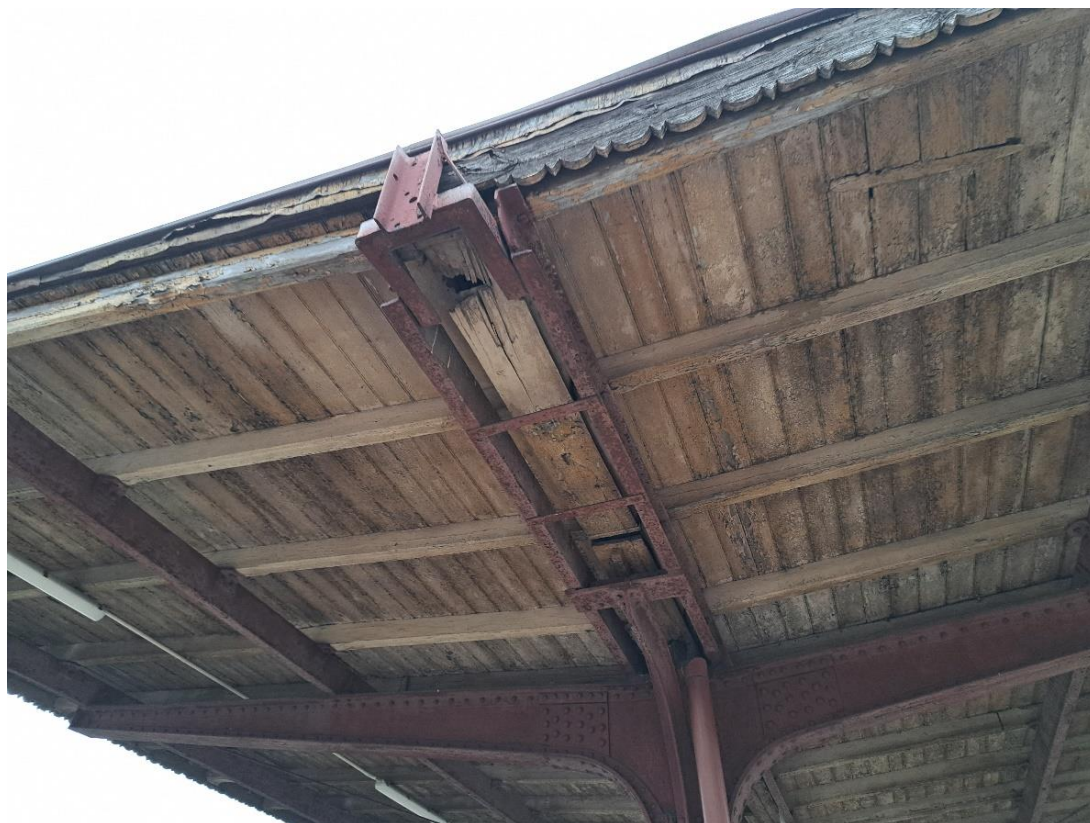
Stan techniczny elementów drewnianych zadaszzenia: obudowa rynny, poszycie, deski czołowe.
